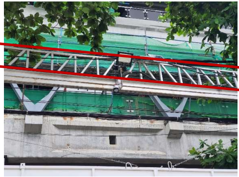
รูปที่ 10 ติดตั้งสเปรย์ละอองน้ำรอบแนวเขตพื้นที่โครงการ
