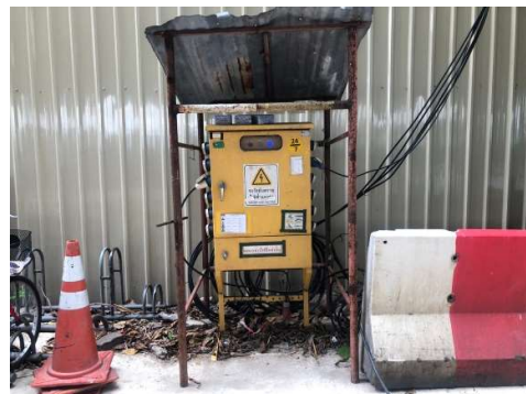
รูปที่ 36 ระบบจ่ายไฟฟ้าภายในโครงการ
