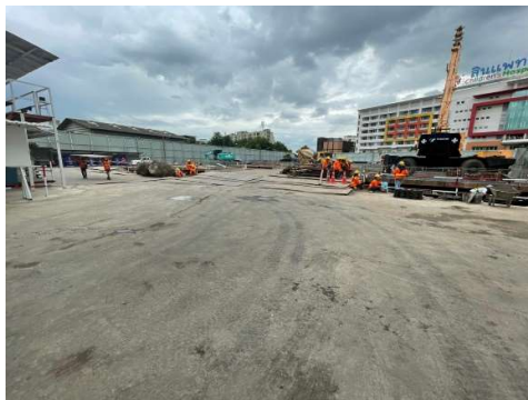
รูปที่ 13 พื้นคอนกรีต/แผ่นเหล็กอย่างหนาปูทั่วบริเวณจะมีรถวิ่งผ่านภายในโครงการ
