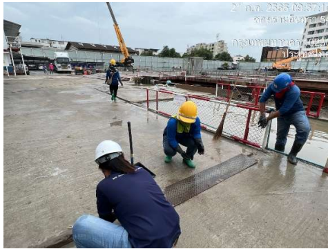
รูปที่ 33 การขุดลอกร่องระบาย
