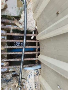
รูปที่ 27 ตะแกรงดักขยะ
