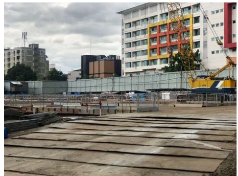
รูปที่ 13 พื้นคอนกรีต/แผ่นเหล็กอย่างหนาปูทั่วบริเวณจะมีรถวิ่งผ่านภายในโครงการ
